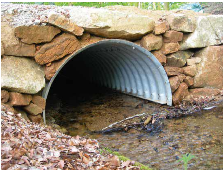
Arche métallique classique (ARMCO) en forêt domaniale Au DUC (89) L'enrochement sec a été ajouté (devant l'enrochement maçonné) pour améliorer la qualité paysagère de l'ouvrage.
